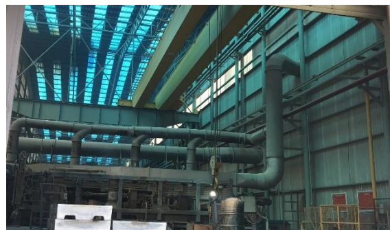
Hình 3.10. Hệ thống xử lý bụi tại công đoạn mạ kẽm nhúng nóng
